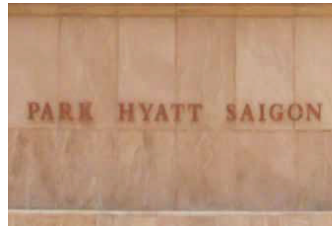
61. Chữ đồng được cắt bằng tia laser Park Hyatt Saigon
