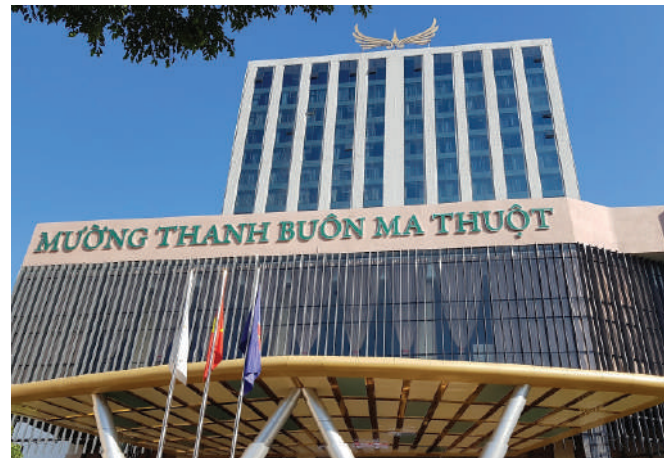
01. Mặt Alu viền inox uốn hộp chiếu sáng đèn led HHX Công trình dự án biển quảng cáo Muong Thanh Buon Ma Thuot
